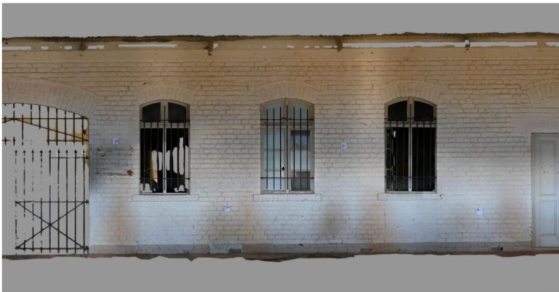
*Ausschnitt des durch Structure-from-Motion erstellen verzerrungsfreien Bildes der Westfassade (erstellt: JA)*
