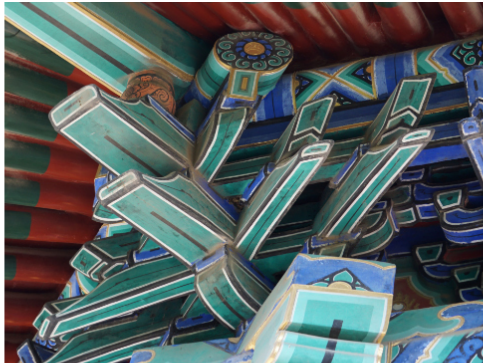
Bild: Guanmiao Pavillon in Peking, Detail Dachkonstruktion. Foto: Nikolaus Koch
