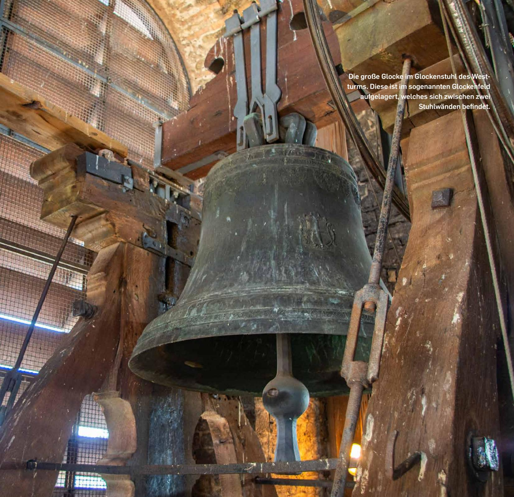
Die große Glocke im Glockenstuhl des Westturms. Diese ist im sogenannten Glockenfeld aufgelagert, welches sich zwischen zwei Stuhlwänden befindet.
