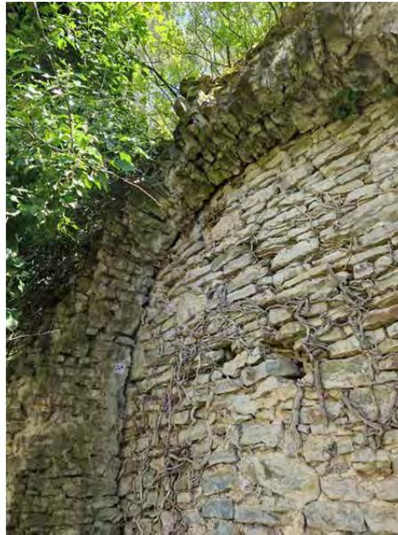
Der gesamte Stützbogen hat sich vom Mauerwerk abgesetzt.
