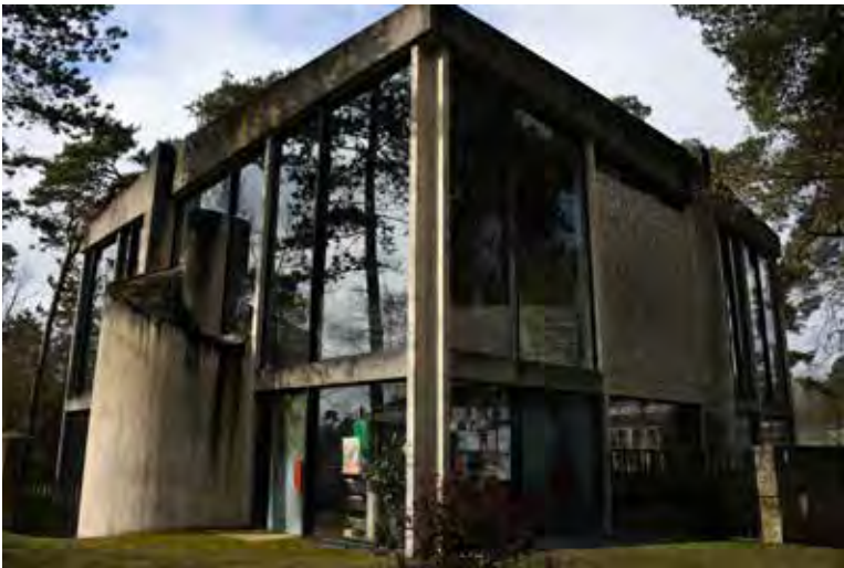
Mannheim, Pfingstbergkirche, Eingang ( Rohn 2024)
