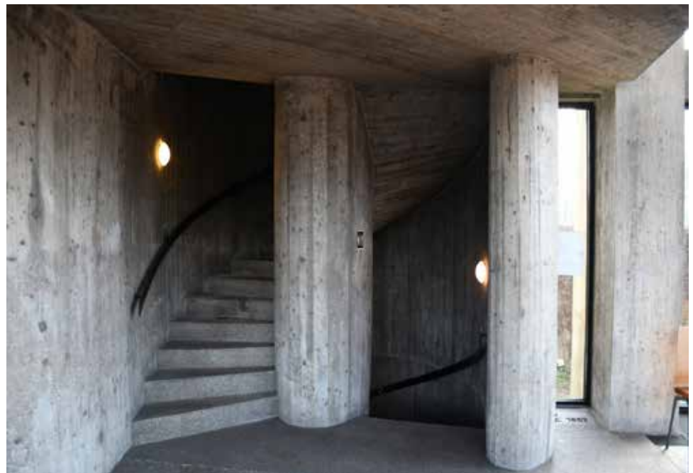
Mannheim, Pfingstbergkirche, Treppenhaus (Rohn 2024)
